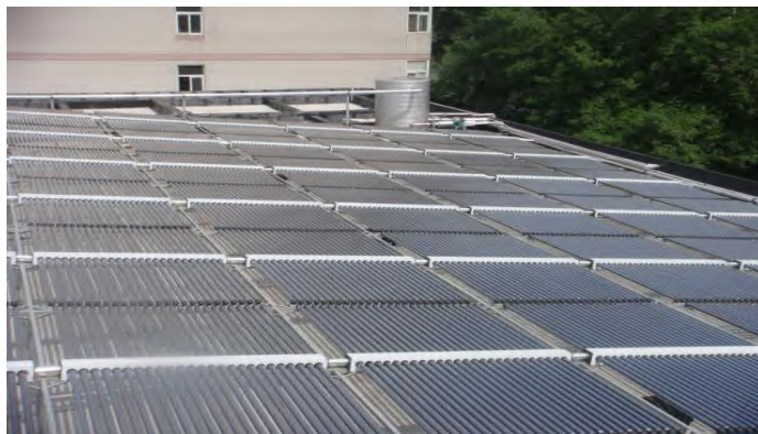
附录图 3 明故宫校区学生浴室太阳能集热系统
