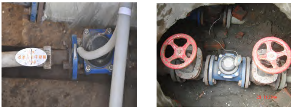
图 4.2 智能水表安装工程
