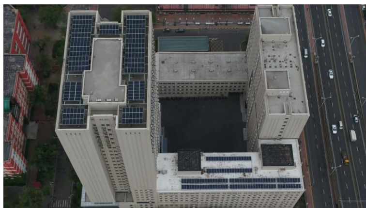
图 8 A03 公寓分布式光伏发电系统（双玻双面光伏组件）
