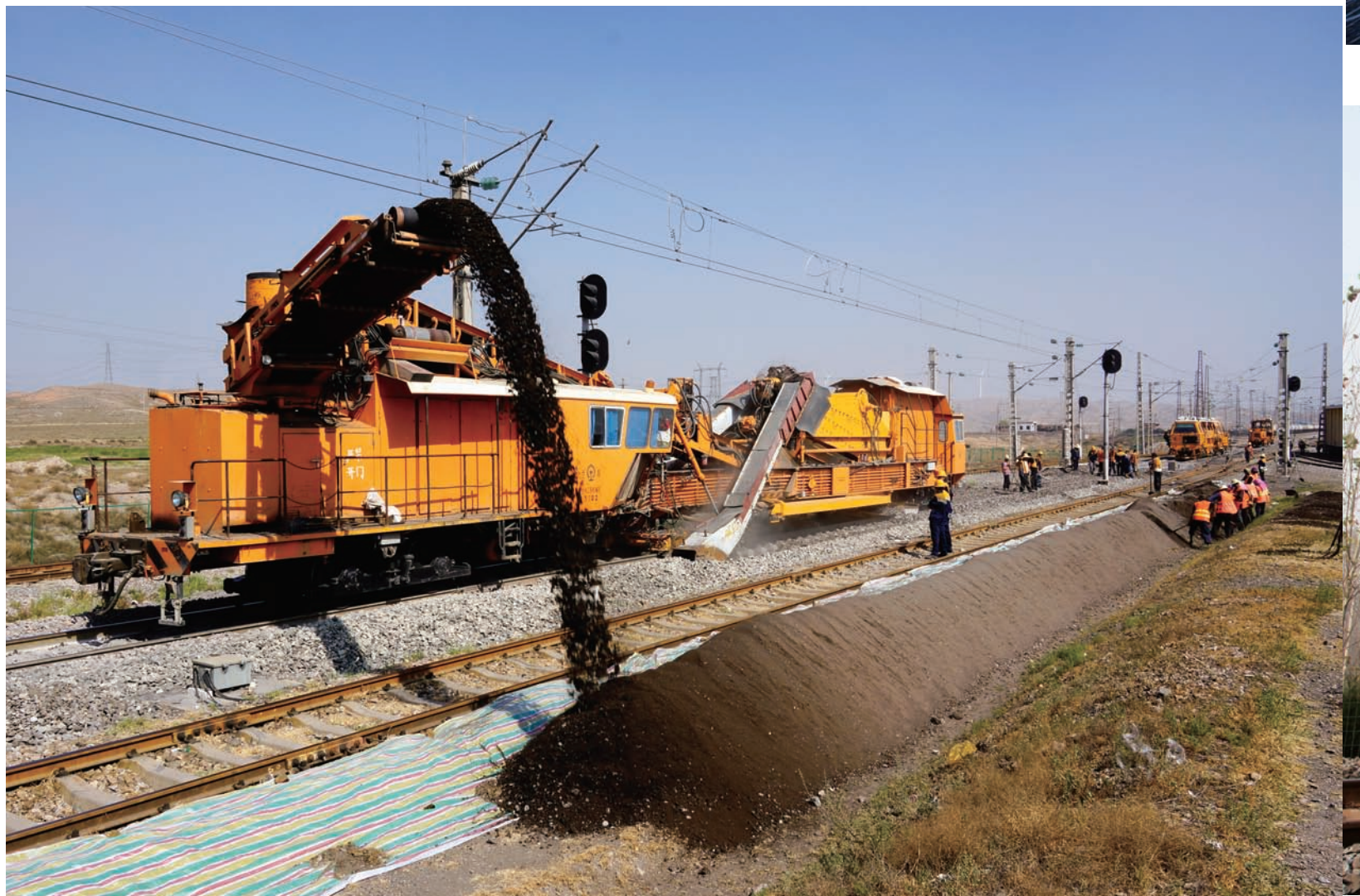
图42 大型养路机械机组在进行线路大修作业
