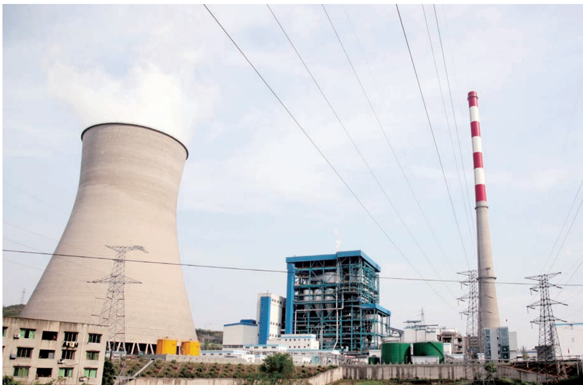
图8 由东锅自主开发设计制造的世界首台600MW超临界CFB锅炉机组在四川白马电站运行
