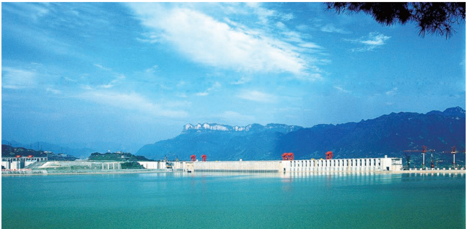
图13 三峡水电站外景
