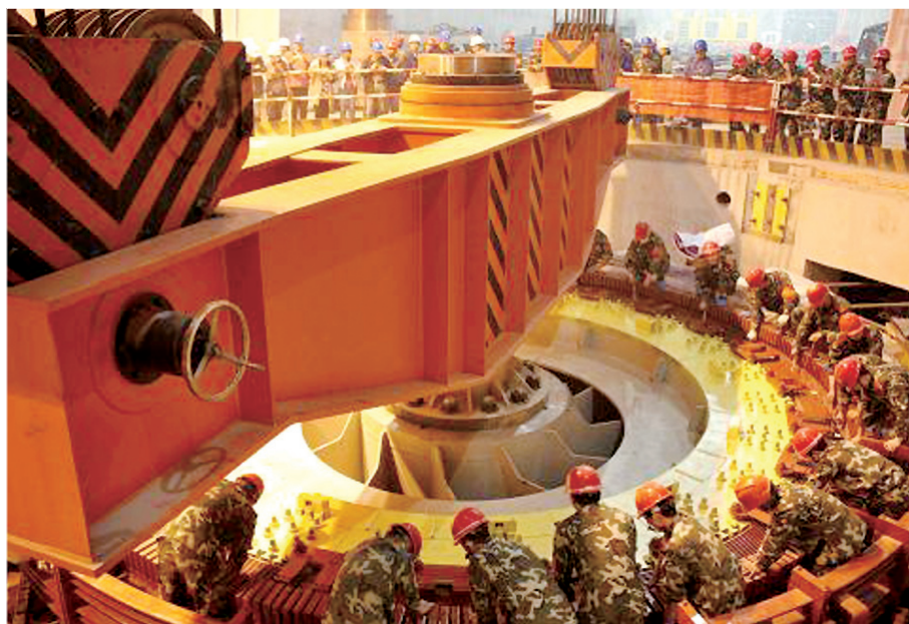
图19 哈电研制的响水涧水电站250MW抽水蓄能机组安装现场
