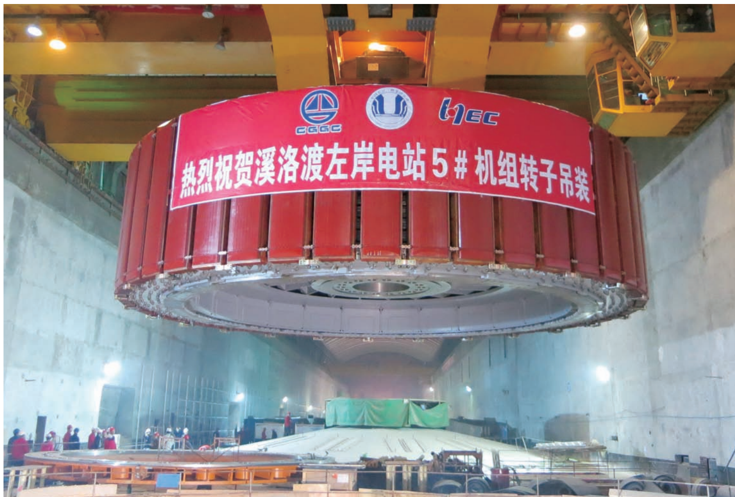
图15 哈电生产的溪洛渡左岸电站770MW水电机组转子正在吊装
