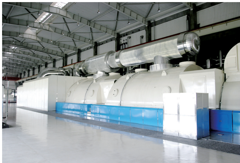
图1 河南沁北电厂一期600MW超临界火电机组
