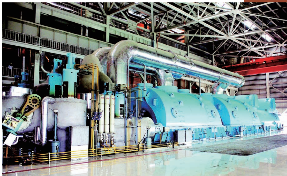
图2 上电集团制造的江苏镇江电厂600MW超临界火电机组
