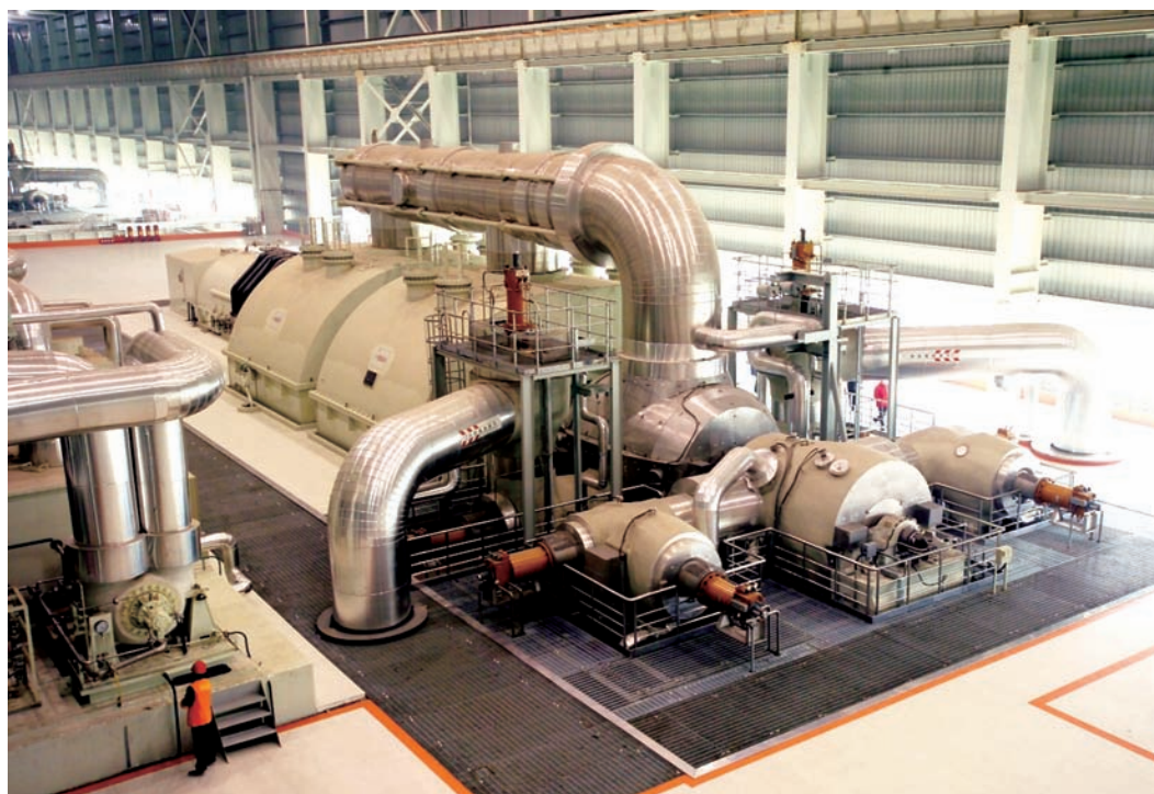
图3 浙江玉环电厂国产首台（套）1000MW超（超）临界火电机组
